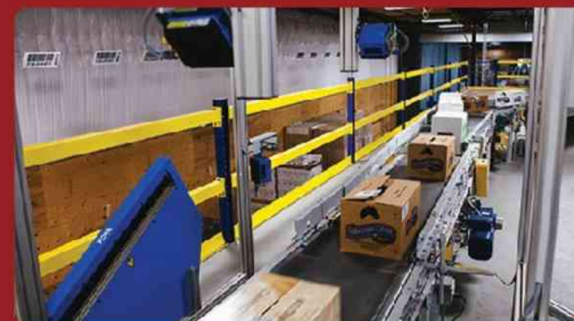
Hệ thống tích hợp đo thể tích và đọc mã code (Demensioning weighting scanning system)
